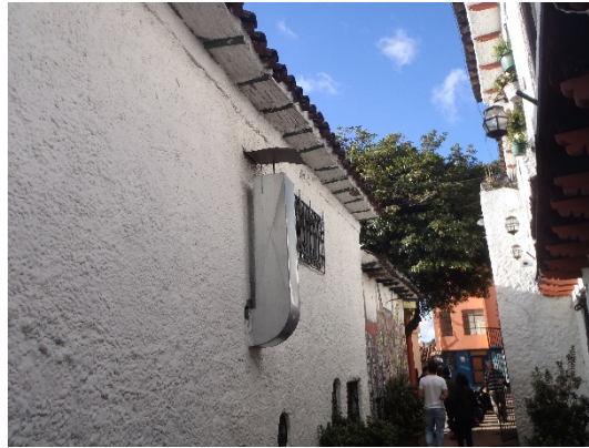
Foto 4. Ducto de desfogue.
